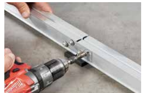
Längsstoß der Unterkonstruktion mit Profilverbinder
